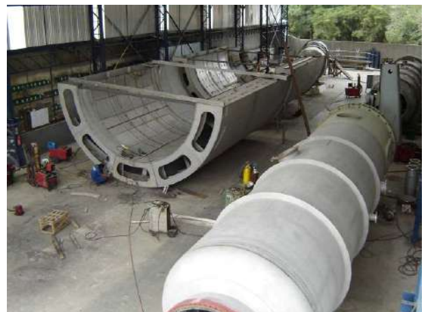
RESFRIADOR DE CAL E FILTROS VISTA INTERNA DE GALPÃO – INOX
